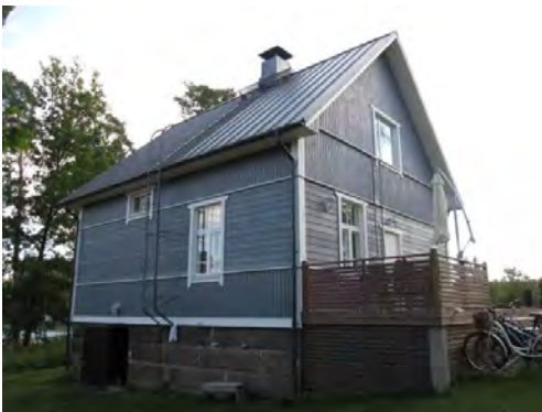
Koillissivu ja luoteispääty.
