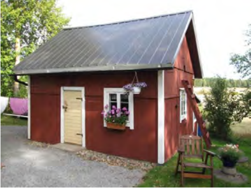
Lounaissivu ja kaakkoispääty.
