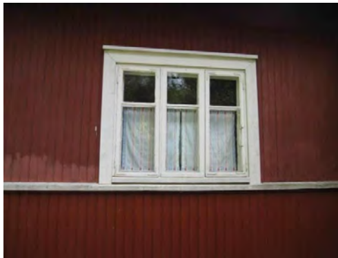
Ikkuna rakennuksen länsisivulla.
