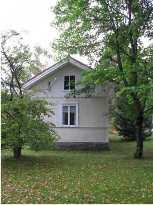
Lounaispääty. Rakennus 2 Vaja
