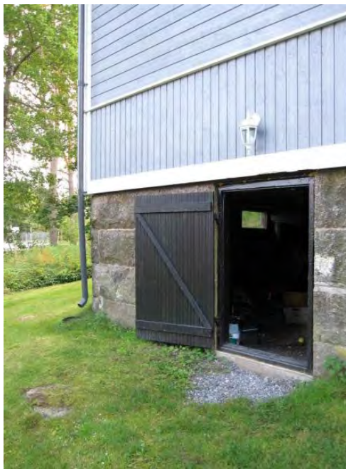
Sisäänkäynti kellariin rakennuksen koillissivulla.
