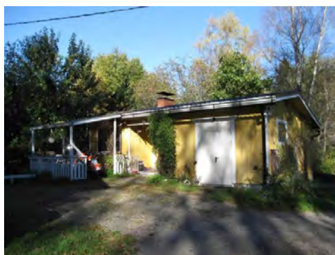
Sauna asuinrakennuksen pohjoispuolella.
