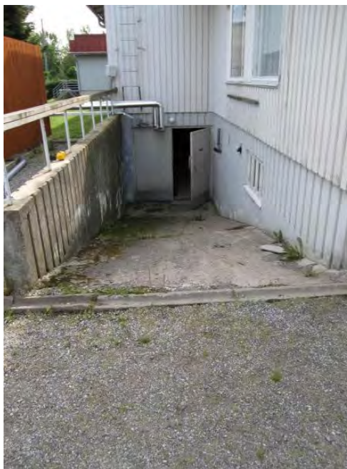
Luiska kellariin rakennuksen itäisivulla.
