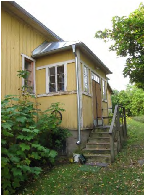
Kuisti rakennuksen pohjoissivulla.
