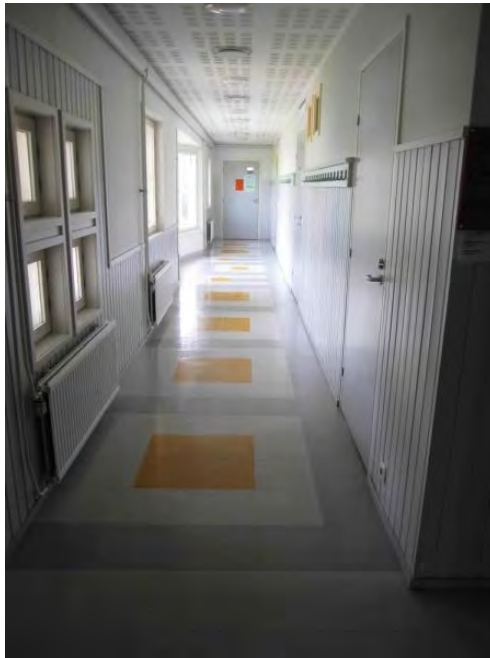
Käytävä rakennuksen itäpuolella.
