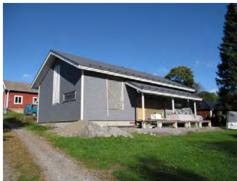
Rakenteilla oleva omakotitalo.
