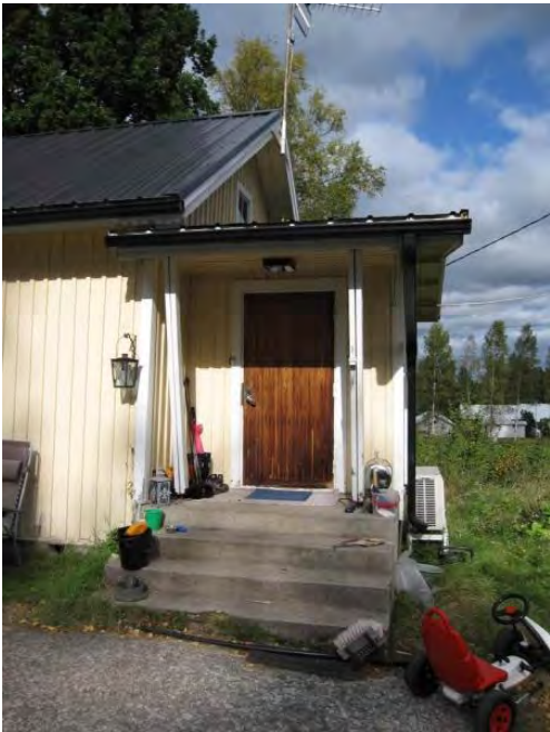
Sisäänkäynti rakennuksen lounaanpuoleisella sivulla.
