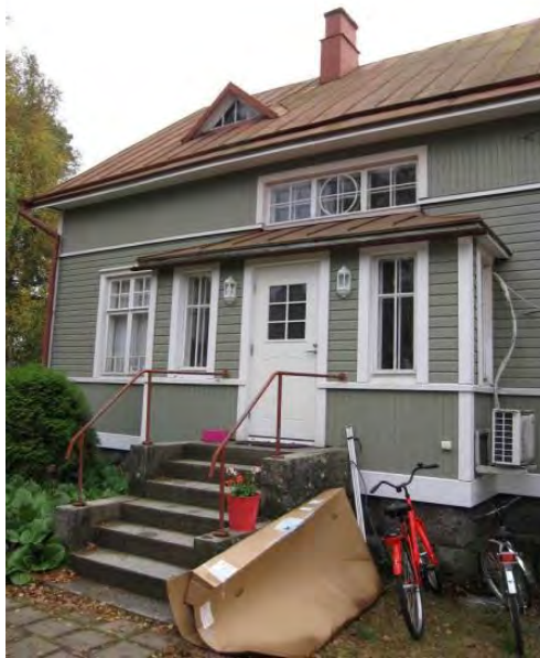
Sisäänkäynti rakennuksen koillissivulla.
