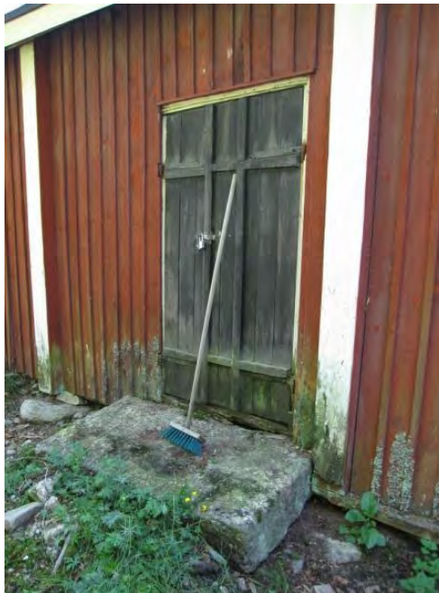
Sisäänkäynti rakennuksen luoteissivulla.
