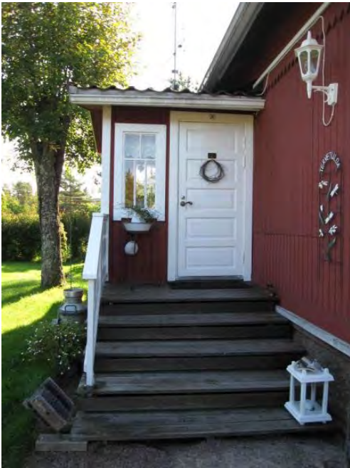
Sisäänkäynti rakennuksen koillissivulla.
