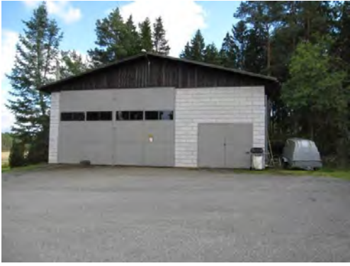
Varastorakennus tontin eteläpuolella.
