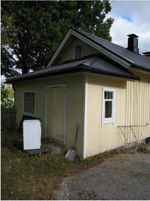
Luoteispääty. Rakennus 2 Sauna
